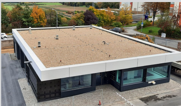
Neubau der Pforte am Campus Bautzen (Stand: Juni 2021)
