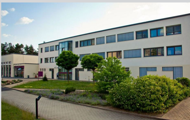
Verwaltungsgebäude und Audimax auf dem Campus Rothenburg
