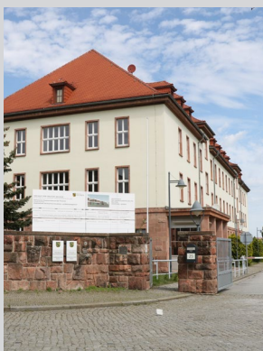
Unterkunftsgebäude am Campus Bautzen – noch im Charme einer ehemaligen Kaserne
