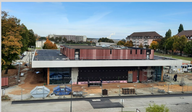
Baufortschritt der Mensa am Campus Bautzen (Stand: Oktober 2021)
